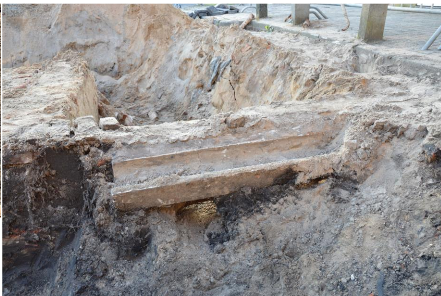
Afbeelding 22: Betonnen goot aan de achterzijde, lopende richting waterput.
