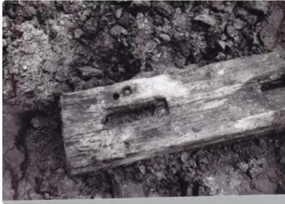
De inkeping van het opgaande werk (pen- en gatverbinding) met toognagels
