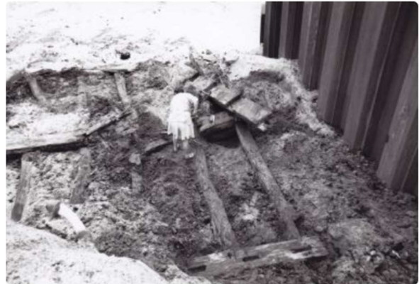
Het schoonmaken van de balken
