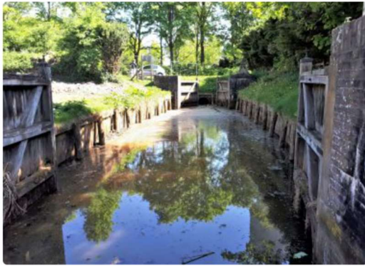
Schutsluisje in de Nijeveense Grift
