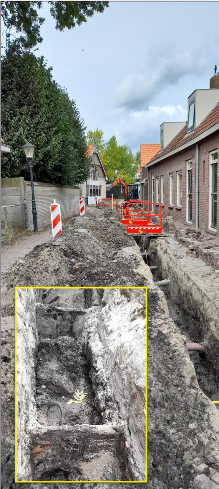
Vernieuwen van de waterleiding in de Kalverstraat. Ter hoogte van nr. 5 zijn twee houten schotten te zien, haaks op de rooilijn. Functie vooralsnog onbekend.
