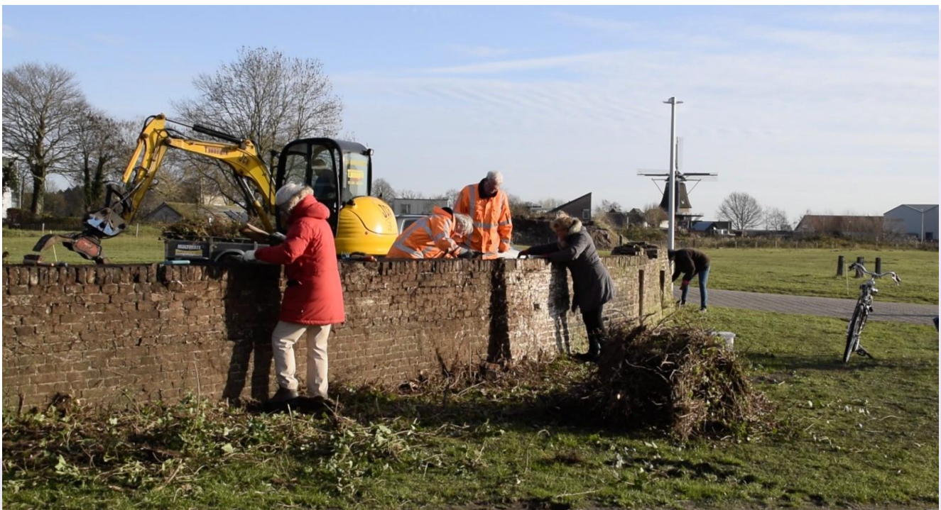
Verwijderen van de begroeiing die de muur zwaar heeft aangetast.
