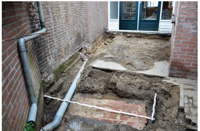
De gemetselde put in situ.
